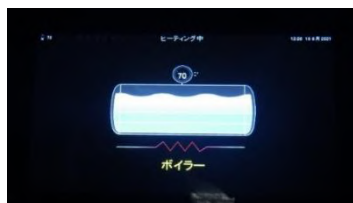
ボイラーヒーティング表示
